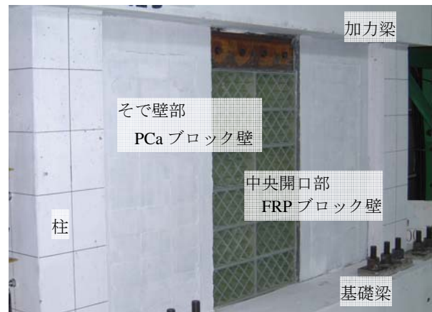
写真-1 補強状況
