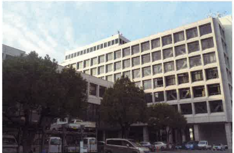
池田・府市合同庁舎（3Q-Brace が窓越しに見える）
